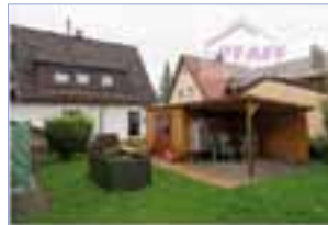
Zuhause ankommen in Schwemmigen! Charmantes Haus mit Pelletheizung +
