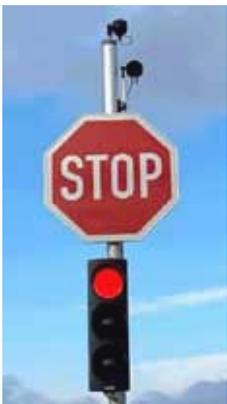
Die Ampelanlage liegt im Zuständigkeitsbereich des Landratsamtes Konstanz. Bei Störungen war und ist die Ortsverwaltung im engen Austausch mit dem Landratsamt Konstanz. Als Fehlerursache konnten technische Probleme mit der Detektion von Fahrzeugen festgestellt werden. Es wurden vorübergehend zusätzliche Kameras installiert.
